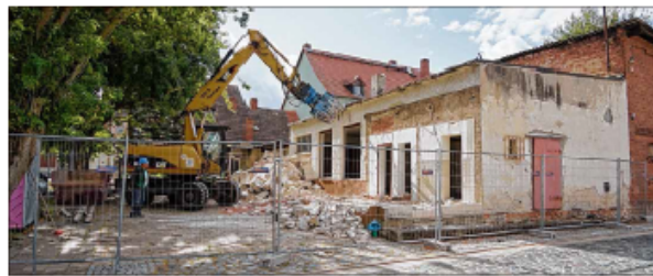
Der alte Getränkemarkt Ecke Marktstraße in Jerichow wird jetzt abgerissen.
