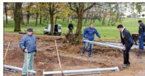
Bei einem Arbeitseinsatz wurde gestern mit dem Aufbau der Spielgeräte für den neuen Spielplatz in Paplitz begonnen. Hier wird die Schaukel gesetzt. Foto: Bettina Schütze
