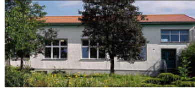
Das Wichtigste ist geschafft: Das Dorfhaus hat ein neues Dach.
