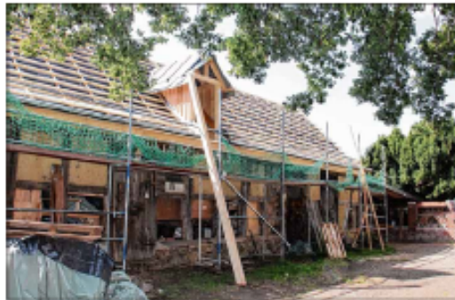
Das ehemalige Stallgebäude im Pfarrhof wird seit Juli saniert. Die Arbeiten sollen im November beendet sein. Foto: Bettina Schütze
