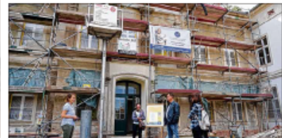
Der Mittelteil des Schlosses ist die letzte Sanierungsetappe hier.
