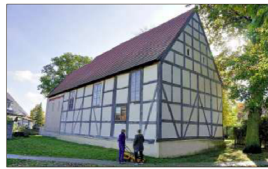
Die Kirche Schlagenthin ist außen ein unscheinbares Gebäude und innen prächtig hergerichtet. Foto: Thomas Skiba
