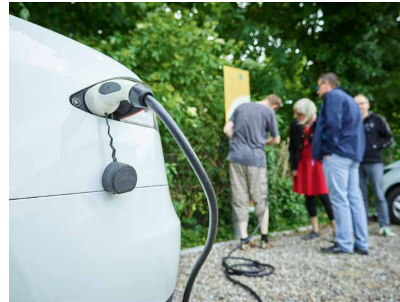
Oben: Installation einer neuen Ladestation auf Usedom
