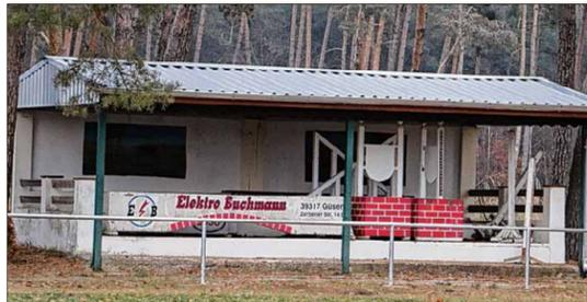
Die Asbestbedachung wurde entfernt und durch eine Trapezblechdeckung ersetzt.
