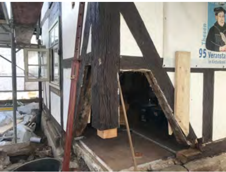
Es geht voran – bald gibt's hier im alten Waschhaus Kaffee und Kuchen
