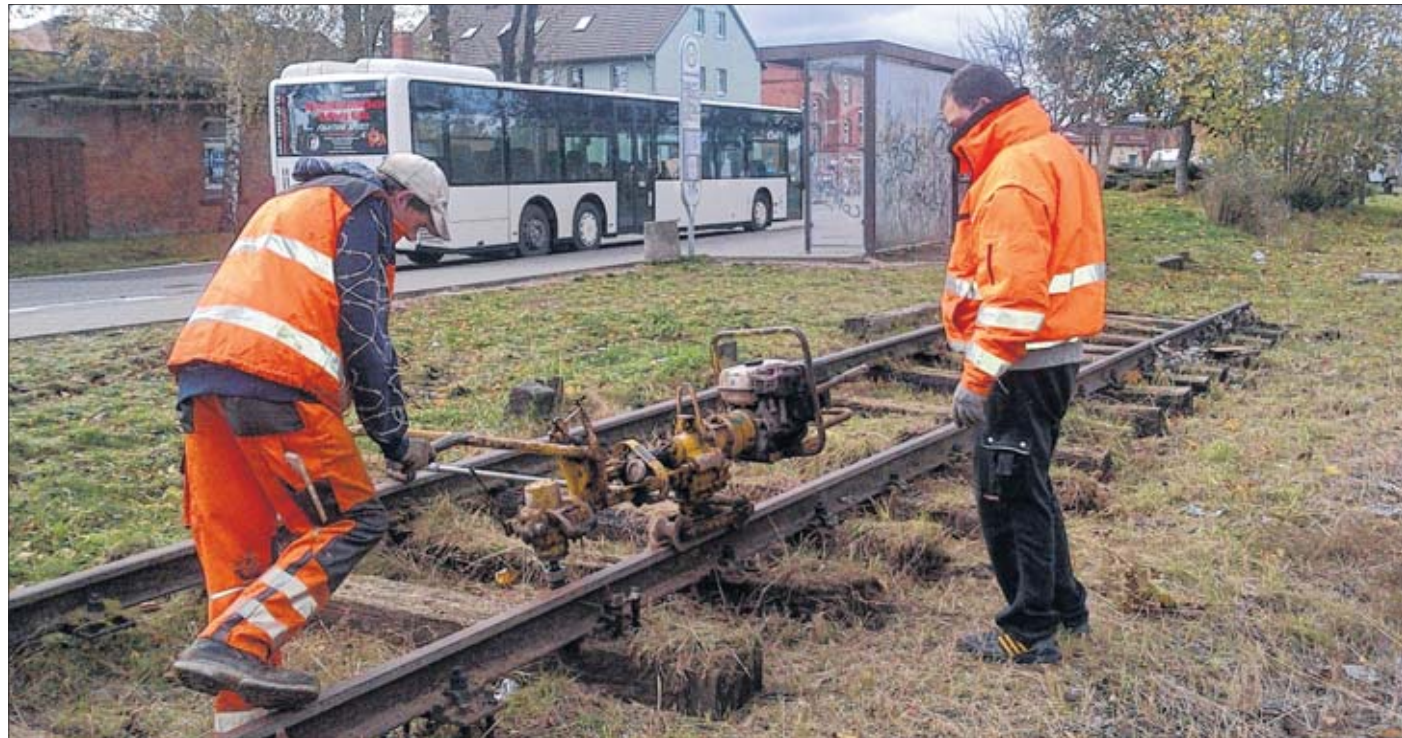
Nicht mehr benötigte Bahngleise und Schwellen am Bahnhof Möckern wurden in den vergangenen Tagen zurückgebaut.
