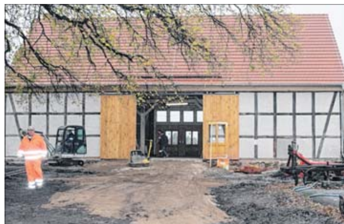
Nicht wieder zu erkennen ist der alte Pfarrhof nach knapp viermonatiger Bauzeit. Fotos (2): Bettina Schütze
