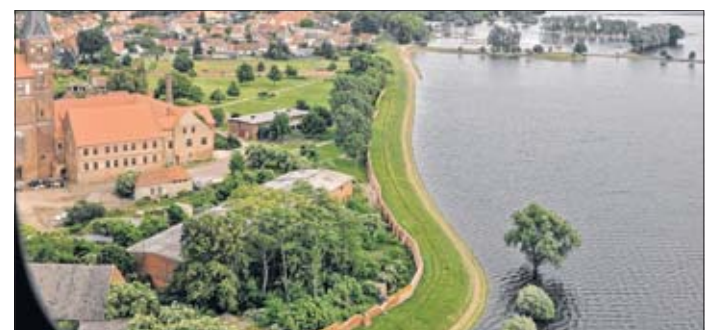
Im Hochwasser gut zu sehen ist, wie die Klostermauer den Deich innen begrenzt – ohne dass eine Böschung oder Berme diese stützt.
