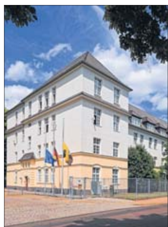
Das Hauptgebäude des Verfassungsschutzes in Magdeburg Osten ist mit giftigen Dämpfen belastet. Foto: dpa
