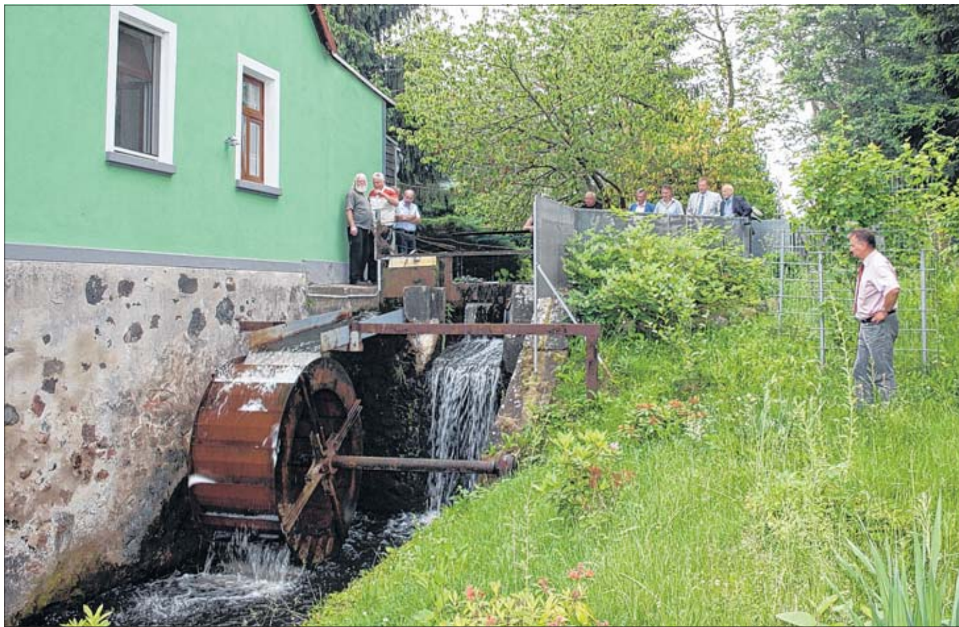
Es dreht sich – das Wasserrad an der Bocksmühle in Schermen. Wirt Wilhelm Westphal hat in Gebäude und Lokal 38 000 Euro investiert. Das Wasserrad erzeugt mittlerweile Strom für den Eigenbedarf. Foto: privat
