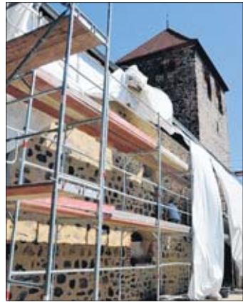
Die eingerüstete Kirche.
