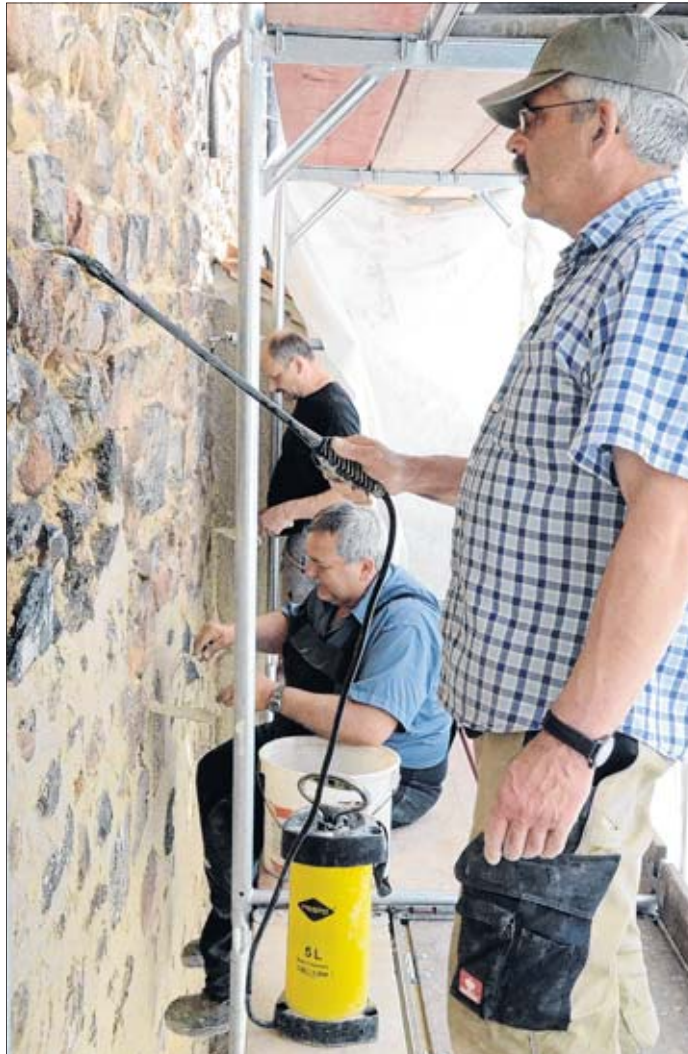
Burkhard Adams, Bernd Hildebrand und Harald Reinsch von der Firma REMA Restaurierungen Magdeburg GmbH füllen die Fugen zwischen den Feldsteinen mit Spezialmörtel. Fotos: Sigrun Tausche
