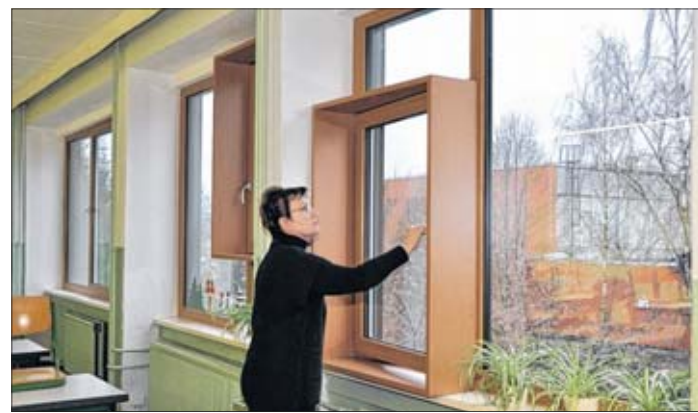
Jutta Mannewitz probiert die neuen Fenster aus. Zusätzliche Rahmen innen als Gestaltungselemente umschließen jeweils die zu öffnenden Bereiche der Fenster. Fotos: Sigrun Tausche
