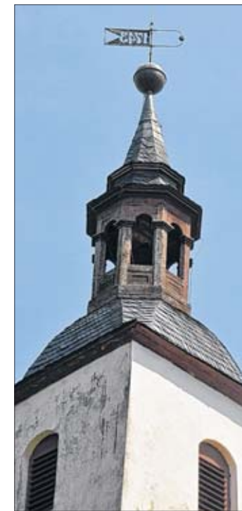
Neue Schiefer, neue Einschalung, neues Holz soll es für den Kirchturm geben. Foto: Krickau
