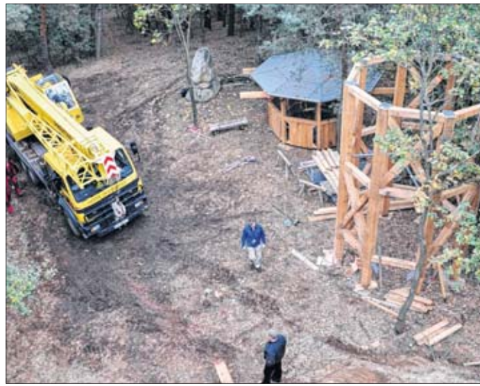
Blick vom untersten Turmsegment auf die Kuppe des Weinbergs vor der Montage des Mittelteils und der Aussichtskanzel.
