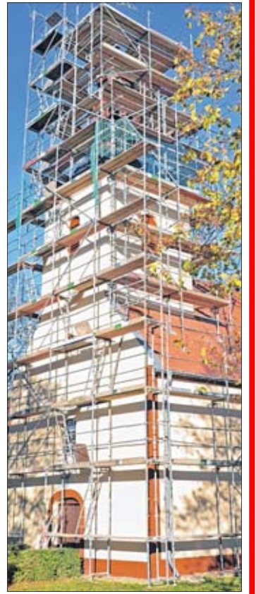
So sah der Turm noch am Montag aus. Jetzt ist das Gerüst weg.
