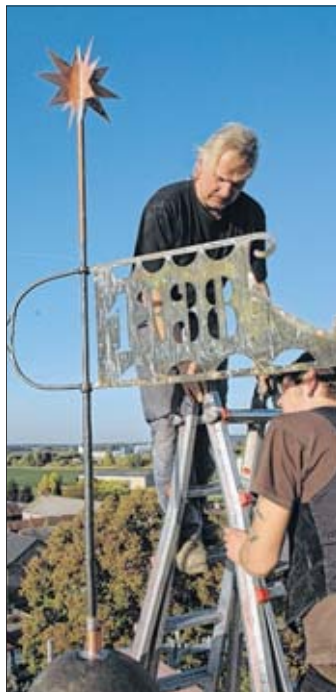
Das Aufsetzen der Turmkugel zum Ende des ersten Bauabschnitts.
