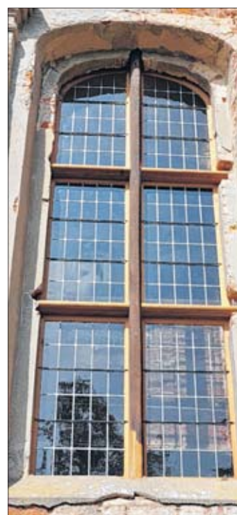
Eines der restaurierten bleiverglasten Fenster, ringsum die sanierten bedürftige Fassade.
