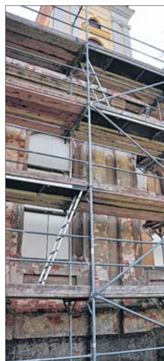
Die Nordseite der Kirche ist eingerüstet, oben ein Stück des sanierten Turms. Fotos: S. Tausche
