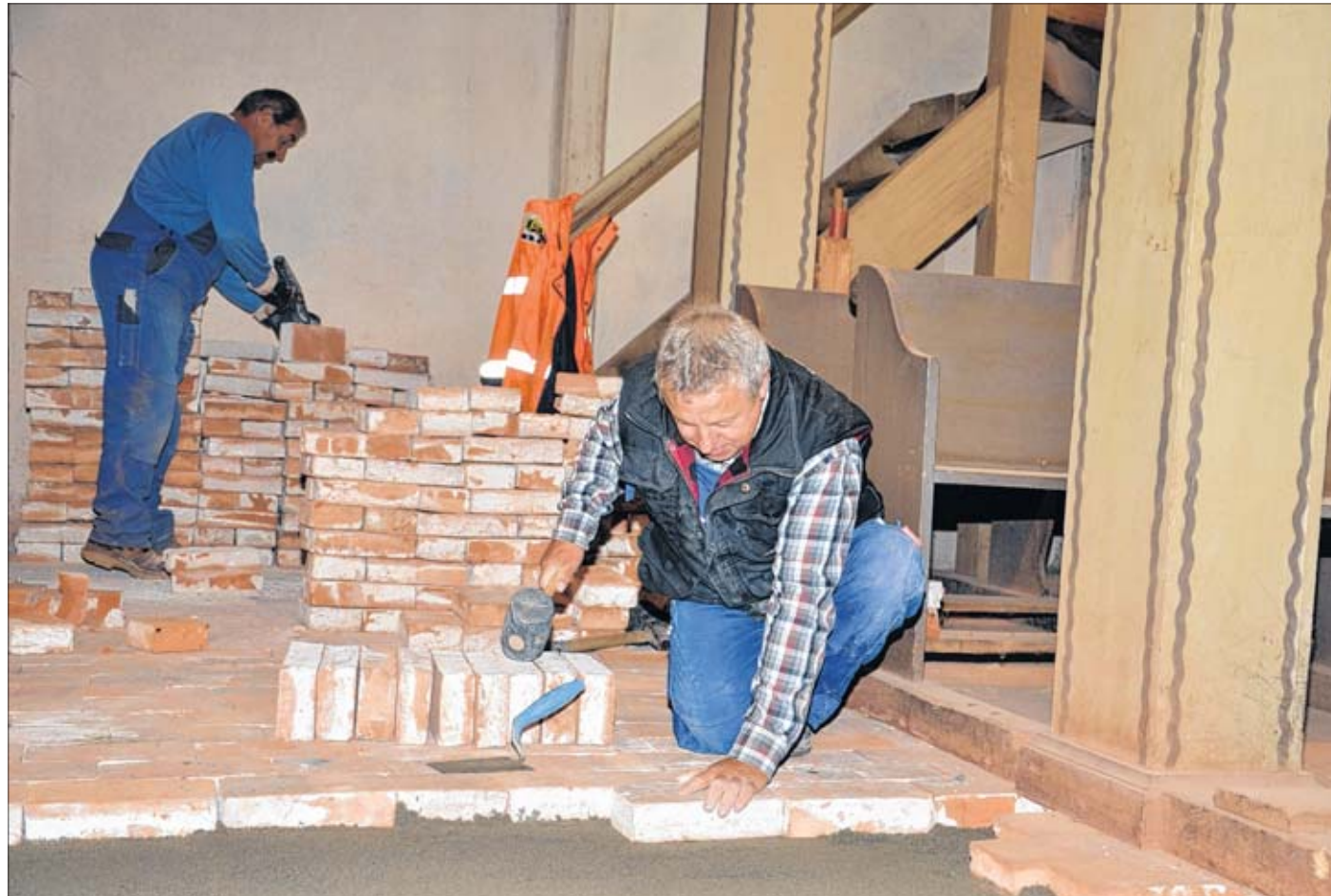
Detlef Kartz (hinten) und Hans-Jürgen Pritzkow sind in diesen Tagen mit den Bauarbeiten in der Parchener Kirche beschäftigt. Kartz befreit die alten Steine vom Mörtel, Pritzkow passt die bearbeiteten Steine wieder ein. Fotos(2): Kristin Schulze
