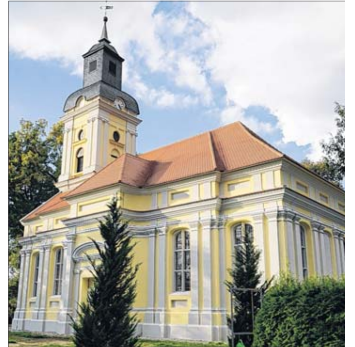
Die Karower Barockkirche ist nun außen komplett saniert.
